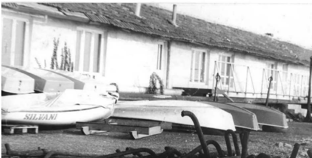
ЯХТКЛУБЪТ СЛЕД РЕМОНТА
